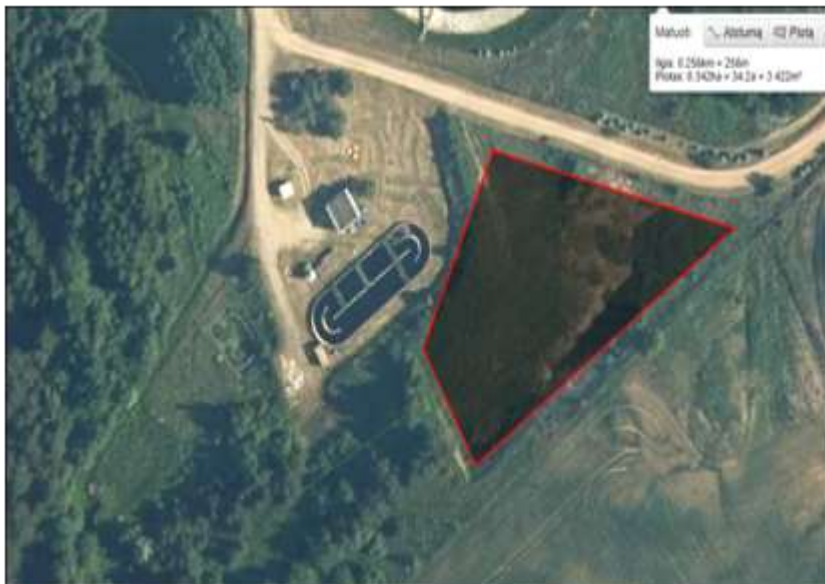
2b pav. Detalizuotas didelių gabaritų atliekų ir mišrių statybos ir griovimo atliekų apdorojimo aikštelės vietos kontūras
